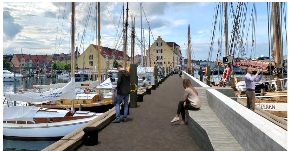
Klimatilpasning af Søndre Havn er en del af Den Blå Kant og bidrager med både beskyttelse og nye byrum.
